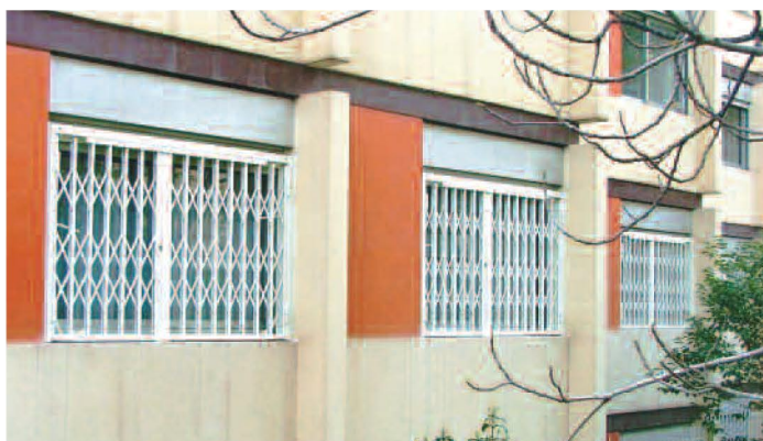
Pose en rez de chaussée d'immeuble
