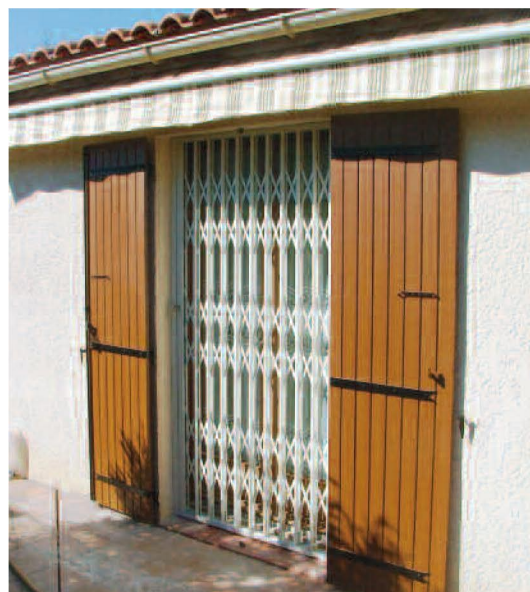
Pose entre chassis et volet
